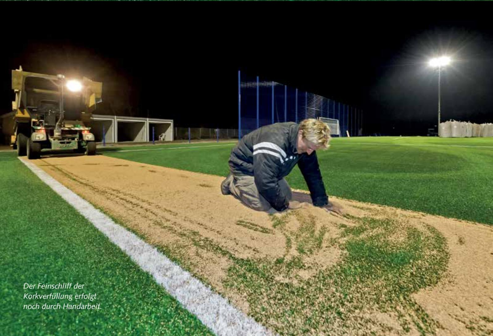
*Der Feinschliff der Korkverfüllung erfolgt noch durch Handarbeit.*
