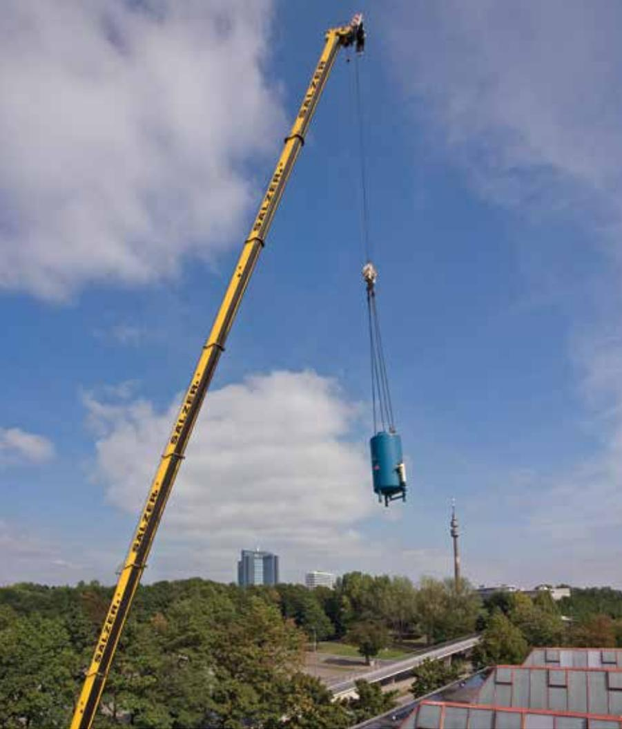
*Mit Hilfe eines Krans wurden im Oktober 2009 die Heizungskomponenten über das Dach des TSC Sportzentrums ausgetauscht.*
